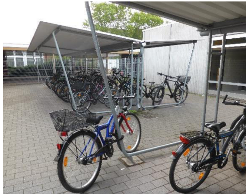
Negativbeispiel: Felgenhalter (ohne Möglichkeit den Rahmen anzuschließen) an der Gerhart-Hauptmann-Schule (Rüsselsheim)
