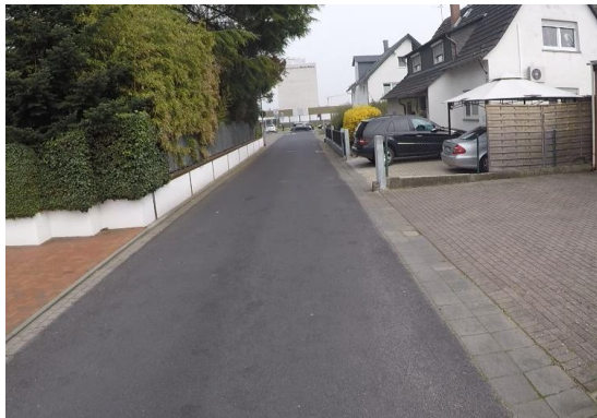
Abbildung 20: Fehlender Gehweg Zeppelinstraße
