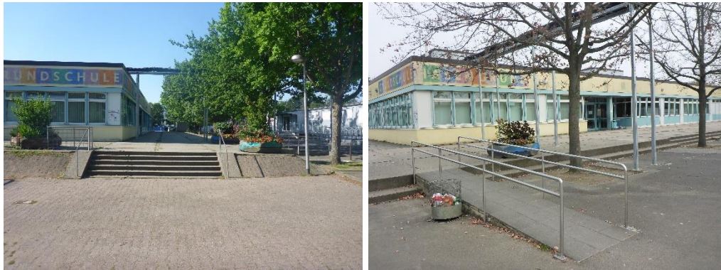
Abbildung 1: Ansicht Schulgebäude Grundschule Hasengrund
