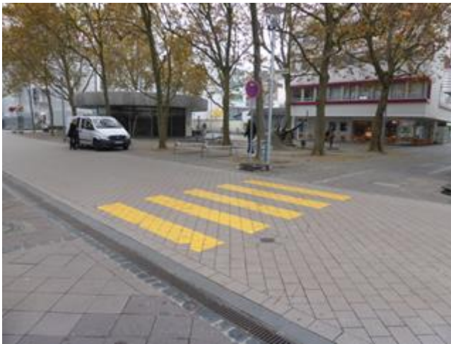
Abbildung 24: provisorischer Fußgängerüberweg Löwenstraße (Blickrichtung West)
