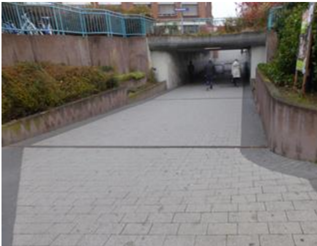
Abbildung 16: Bahn-Unterführung Markstraße (Blickrichtung Süd)
