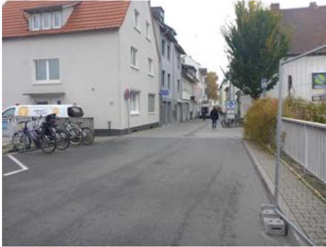
Abbildung 20: Brücke Grabenstraße (Blickrichtung West)
