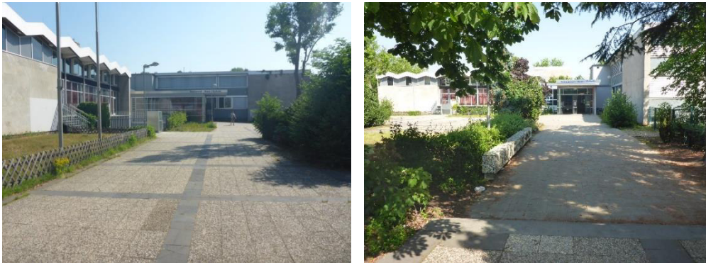
Abbildung 1: Ansicht Schulgebäude Immanuel-Kant-Schule
