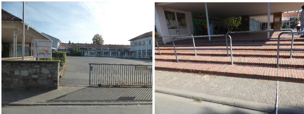
Abbildung 1: Schuleingang Nackenheimer Straße
