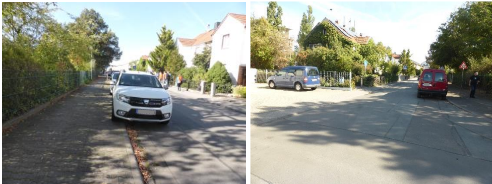
Abbildung 15: Südlicher Gehweg sowie Querungsbereich und Zebrastreifen Bischofsheimer Straße
