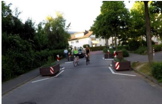
vorgezogener Seitenraum in Dossenheim
