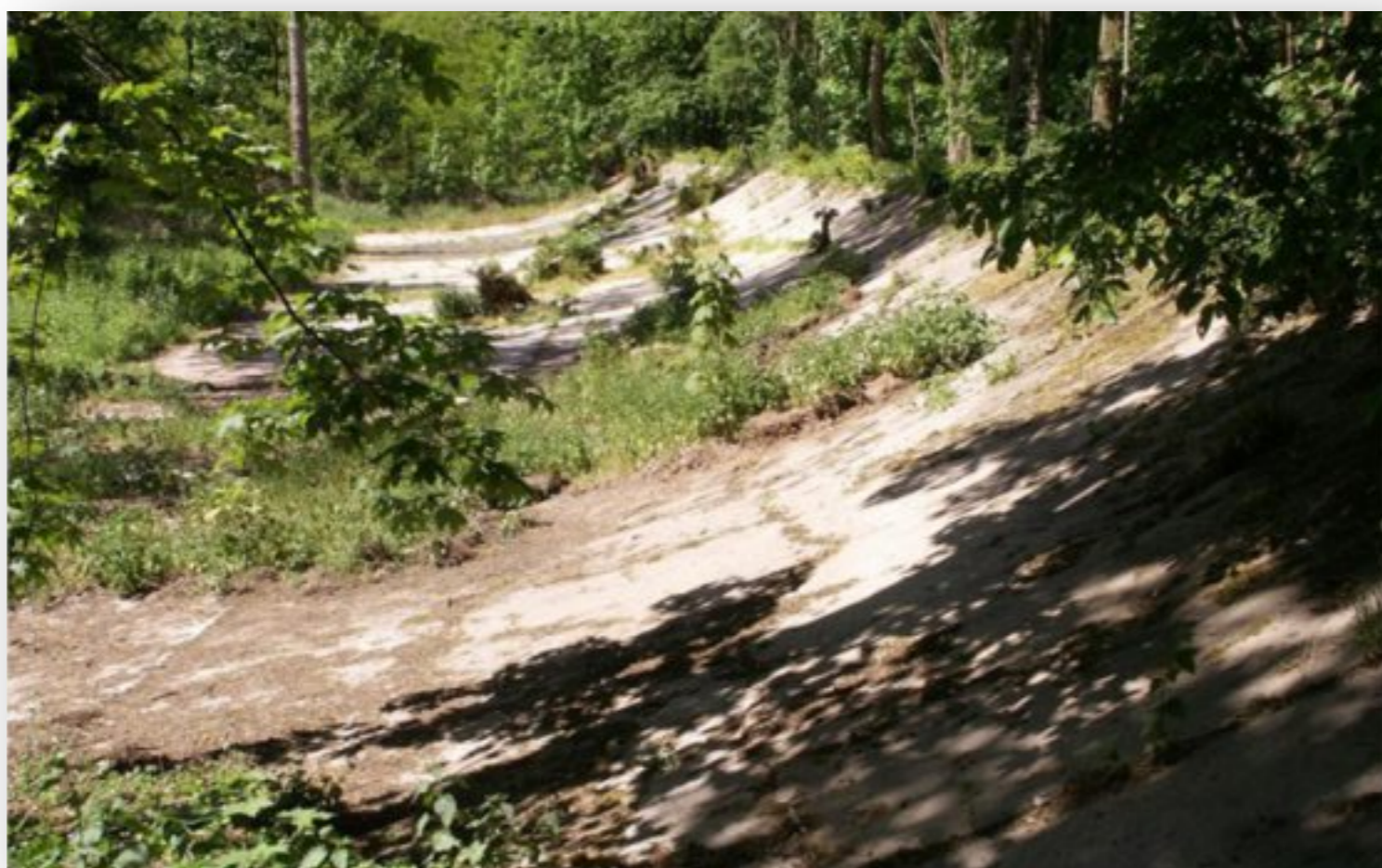
Zustand der 100 Jahre alten Rennstrecke in 2019
