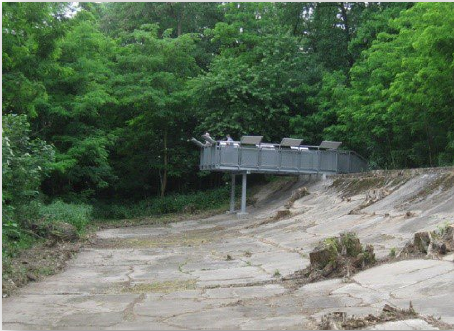
Besucher-Plattform (Stahlkonstruktion) an der Nordkurve der Opelbahn, 2013
